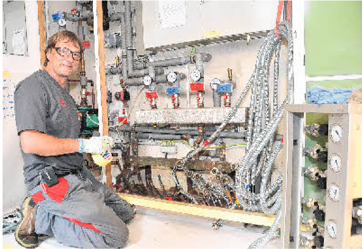
Heizungsbaumeister Klaus Scheuerpflug aus Ansbach bei Fürth in der Heizungszentrale der Stiftskirche. Er und sein Team haben diese Woche die Fußbodenheizung mit ihrer rund einen Kilometer langen Rohrleitung in elf Heizkreisen auf Vordermann gebracht.
