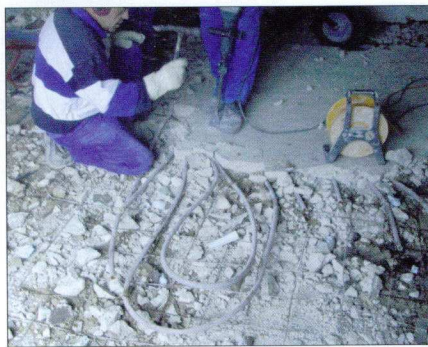
Ein kostspieliger Abbruch der Heizung ist nicht mehr erforderlich.
