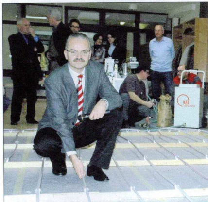
Geschäftsführer Karim Kudsi mit einer freigelegten Fußbodenheizung.
