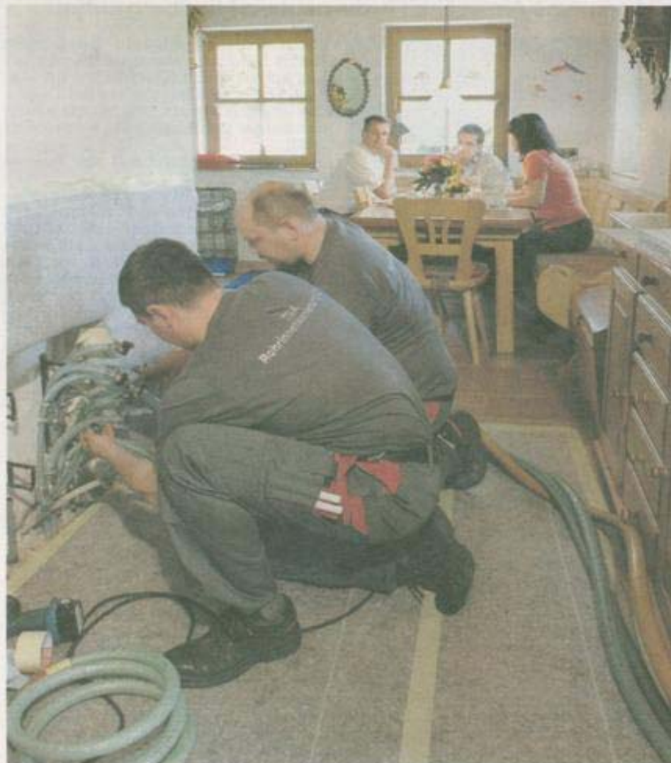
Zwei TGA-Mitarbeiter erneuern die Kunststoffrohre einer maroden Fußbodenheizung in einer Privatwohnung. Foto: oh
