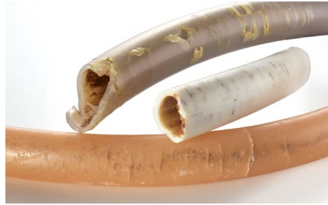
▲ Bild 2 • Sauerstoffdiffusion führt zu Versprödung und Undichtigkeiten.
