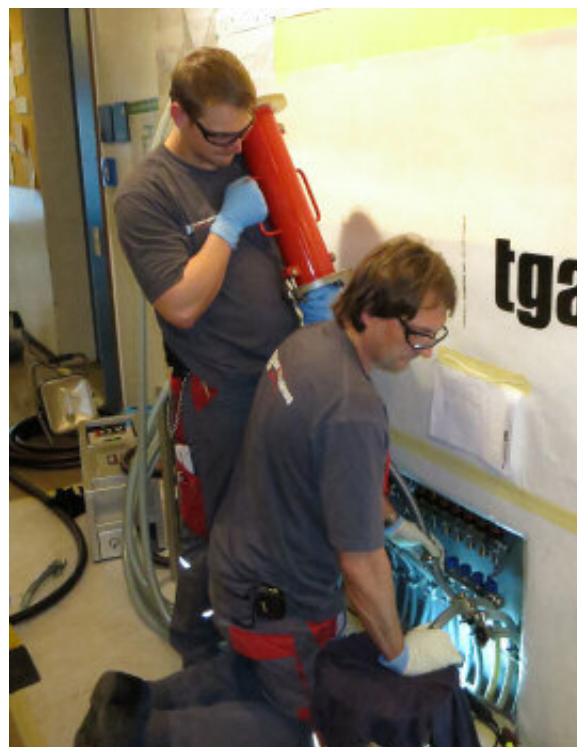
▲ Beschichtung eines Fußbodenheizkreises mittels Beschichtungsmaterial
