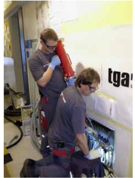
Beschichtung eines Fußbodenheizkreises nach der Reinigung mit der sauerstoffdiffusionsdichten Harzmischung.
