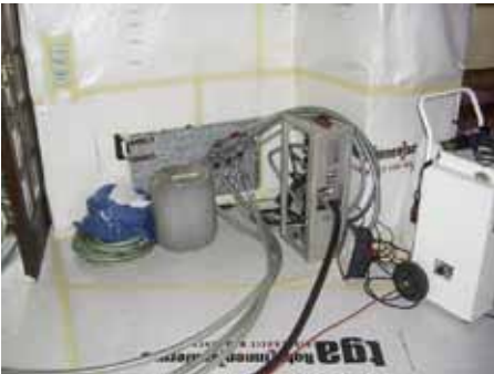
Im Bereich um den Verteiler werden auch die Wände durch Abkleben besonders geschützt. Das spart Nerven bei der Bauherrschaft.
