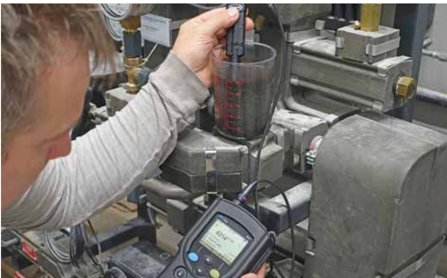
Eingebrachte Inhibitoren können bei falscher oder überdosierter Anwendung extrem hohe Leitfähigkeiten nach sich ziehen.
