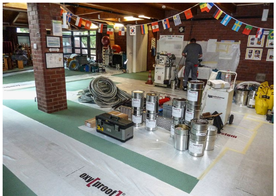
Bild: TGA Rohrrinnensanierung AG
