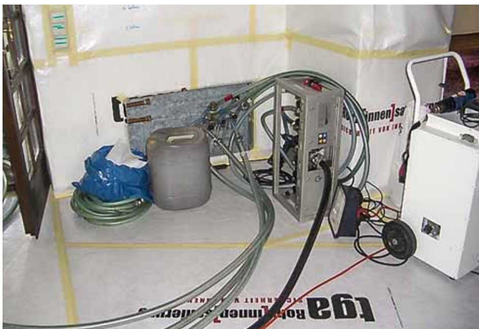
Das Equipment zur Sanierung vor einem Verteiler
