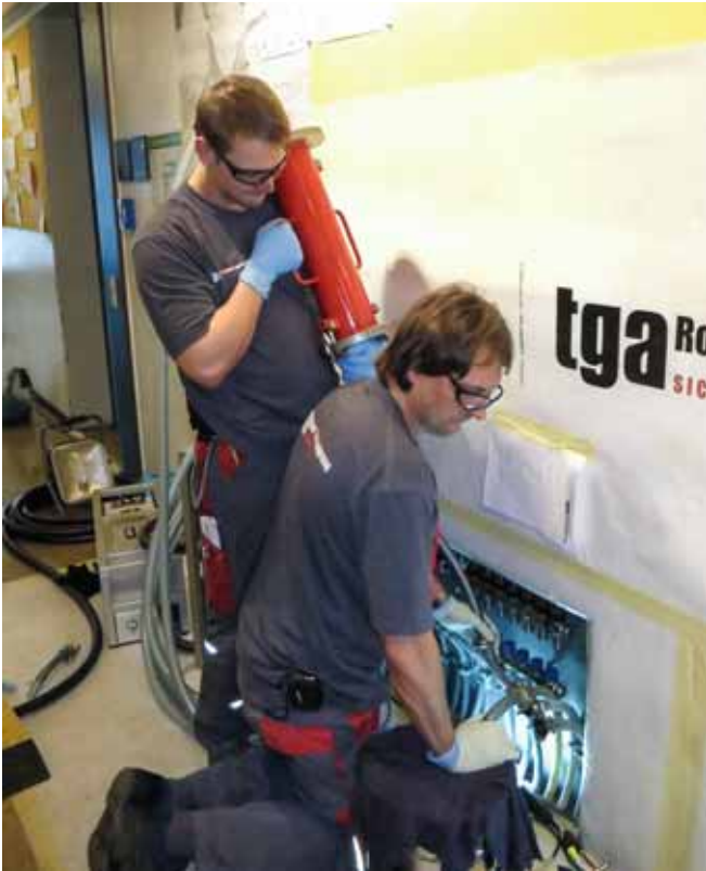
Montagearbeiten während der Sanierung
