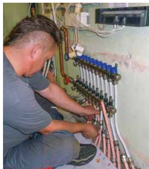
■ Arbeiten am Verteiler
